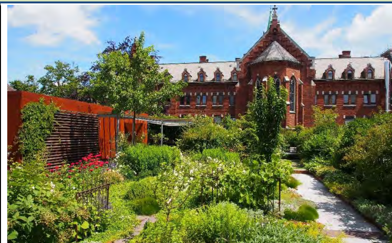
Bild: Dachgarten Diakonissenkrankenhaus Augsburg (Quelle: © Evangelische Diakonissenanstalt)
